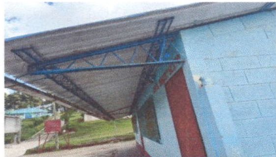
Foto 12: Reparacion de bajada de agua pluvial, tubo PVC
