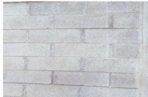
Foto 10: pintado de muros interiores y exteriores
