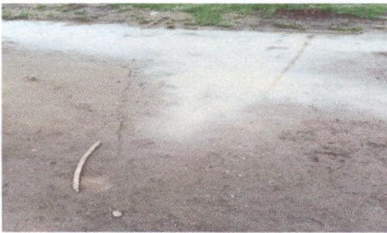
Foto 9: Reparacion de loza de patio
