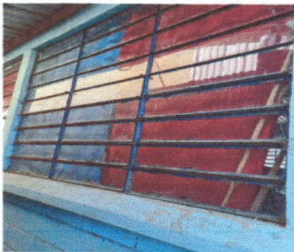
Foto 3: colocacion de ventanales de metal
