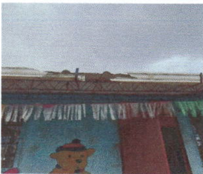
Foto 5: cambio de canales
