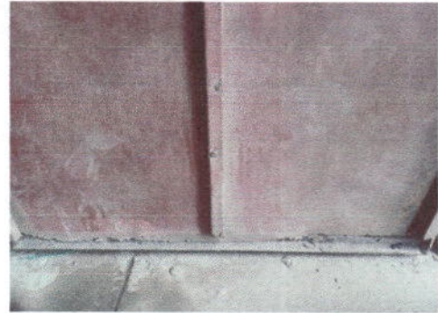
Foto 2: sustitucion de puertas en el baño
