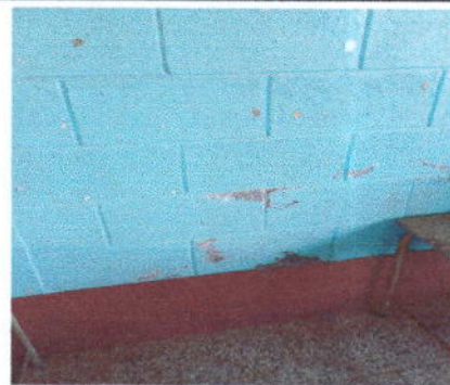
Foto 6: Pintura en muros interiores y exteriores
